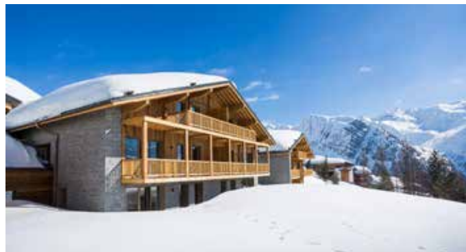
RESIDENCE LE HAMEAU DE BARTHÉLÉMY LA ROSIÈRE (73)
