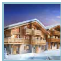
TRAVAUX EN COURS LE PRÉ D'ANNE-CHLOÉ SAMÖENS (74)
