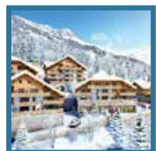
TRAVAUX EN COURS LES EDELWEISS VAUJANY (38)
