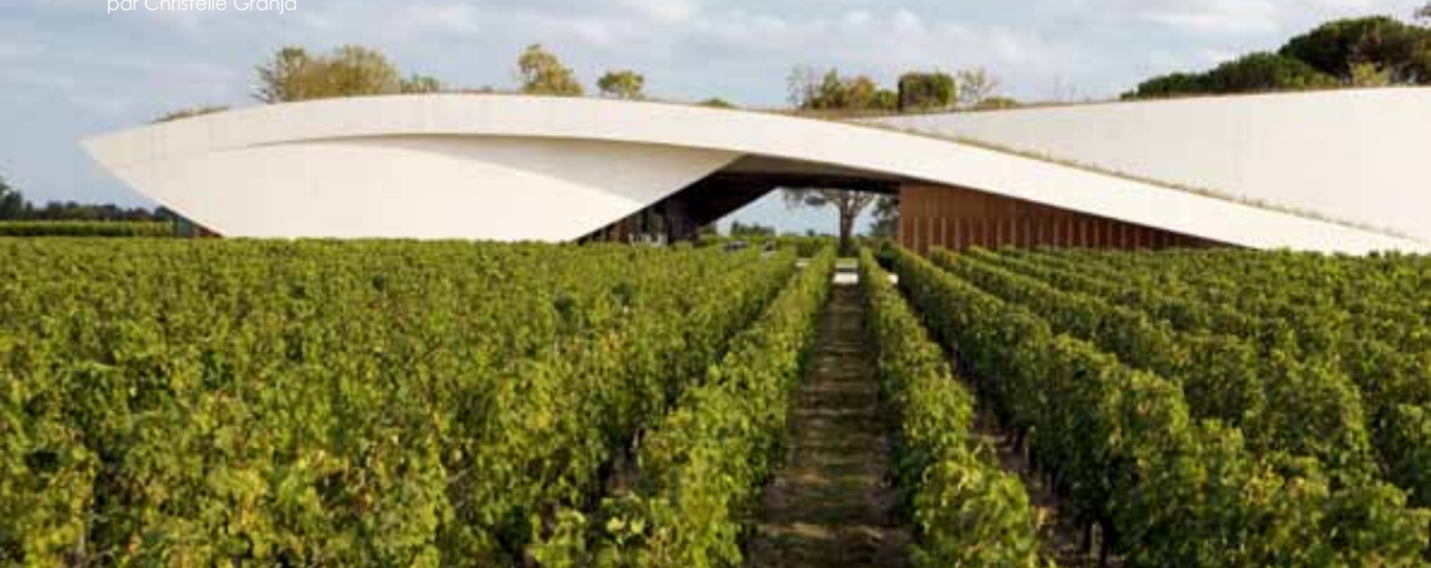
Les nouveaux chais du Château Cheval Blanc, signés de l'architecte Christian de Portzamparc - photo © G.Uféras
