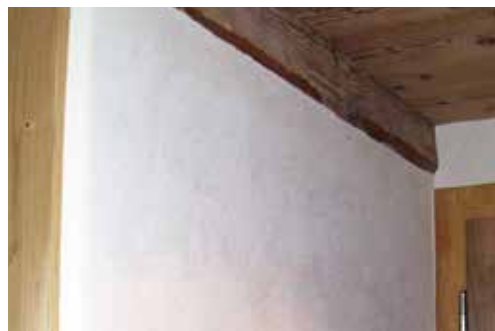
Parement Bois et enduit plâtre blanc
